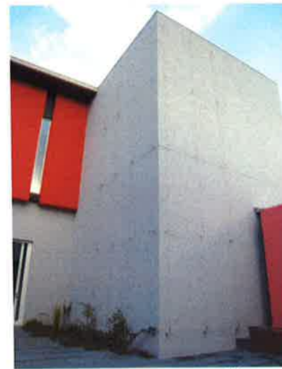
施工後 11ヶ月後
