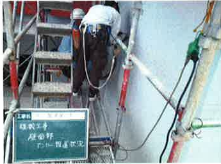
壁面部 アンカー設置状況
